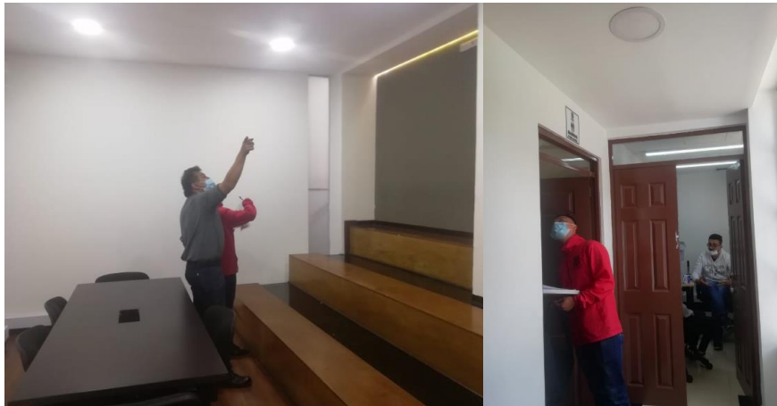
Ilustración 2 Imagen de seguimiento del sistema de Luminarias ALS
